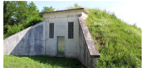
Réservoir de Malans
