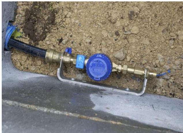
**Cette isolation, mise en place durant la période hivernale, pourra être retirée le 1er mars afin d'éviter la condensation sur les écrans des compteurs.**
