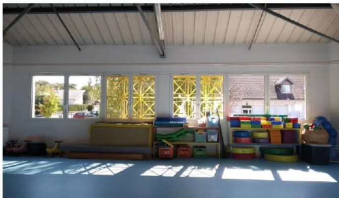
Vues sur les menuiseries de la salle de motricité
