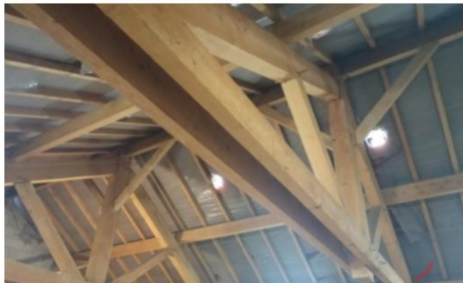
Vues sur les rampants de toiture
