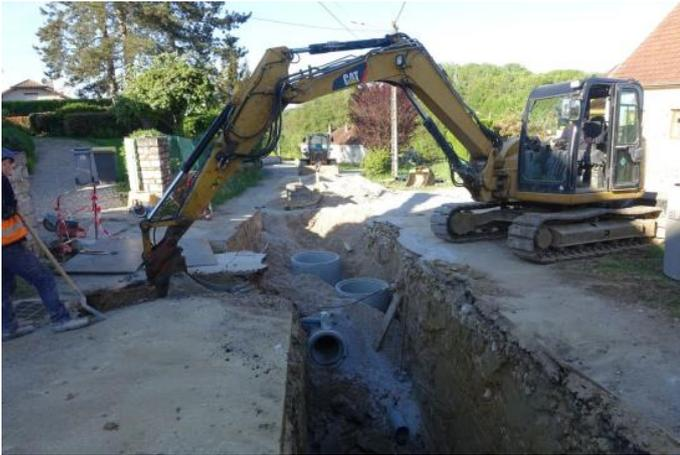
Tous les réseaux d'assainissement de ce bassin versant ont été remplacés et doublés pour une mise en séparatif des eaux usées et des eaux pluviales soit plus de 3600 mètres de canalisations posés.
